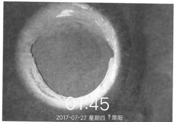
(图3c) D199旋挖成孔过程中，护筒顶下4.7m位置，褥垫层一圈坍塌
