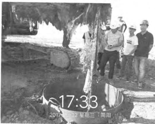
(图3a) 成孔过程中挖出地基处理褥垫层使用的土工布
